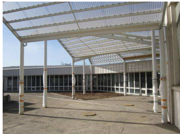
Figure 4 : Demi-pension au collège Saint Exupéry à Savenay
